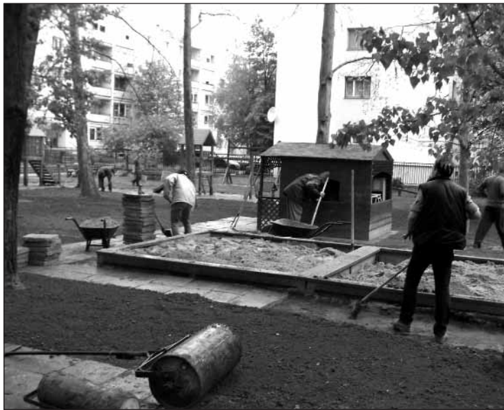
A szakadó esőben is folyt a munka Kölcsey óvoda udvarán
