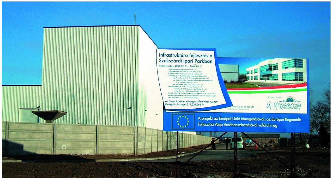
Uniói támogatásból és a város saját erejéből valósult meg a park infrastruktúra-fejlesztése
