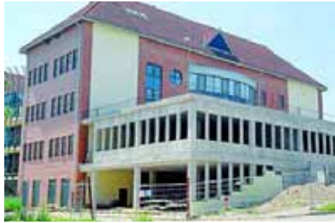
Az új sürgősségi osztály a műtöbökkészaki oldalához csatlakozva épül
