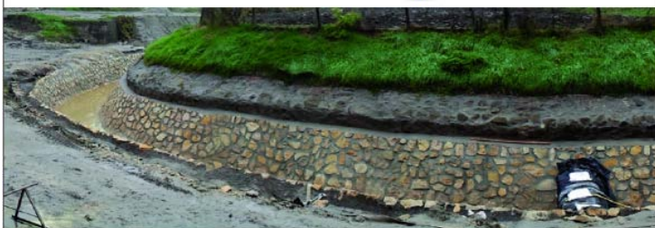
A Szekszárd-Bátai-főcsatorna Bátai-zsilip feletti burkolt mederszakasza Fotó: Wolfiurt Lázló
